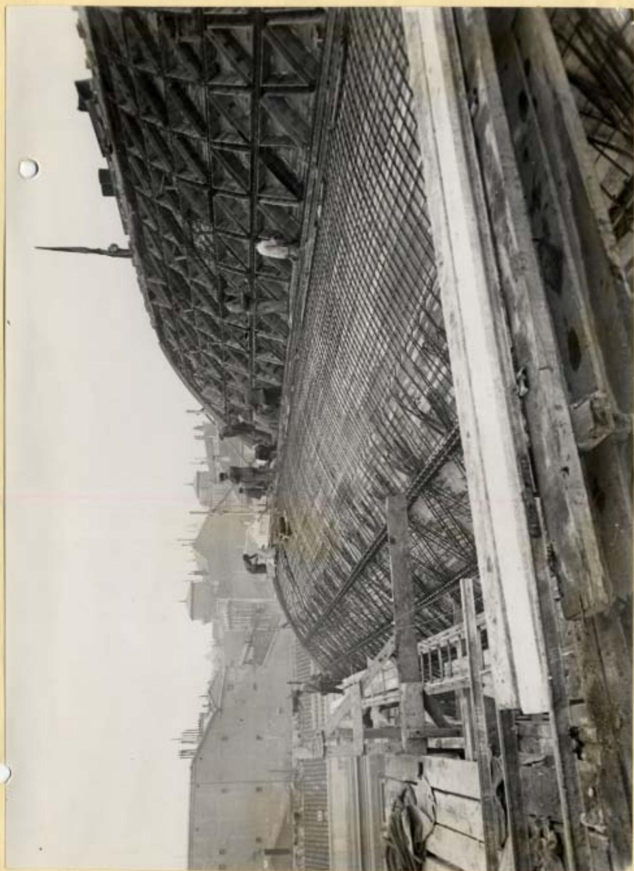
Fig 38 - Vista parcial durante la colocación de armaduras.
