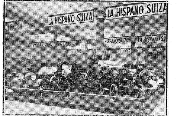
El stand de La Hispano-Suiza, con la más antigua y la más reciente producción de la marca. El coche núm. 4 de 1902 que se mantiene aún en estado de funcionamiento y el formidable motor de aviación enfriado por aire de 14 cilindros en doble estrella, con 45 litros de cilindrada y de una potencia de 1.000 caballos
